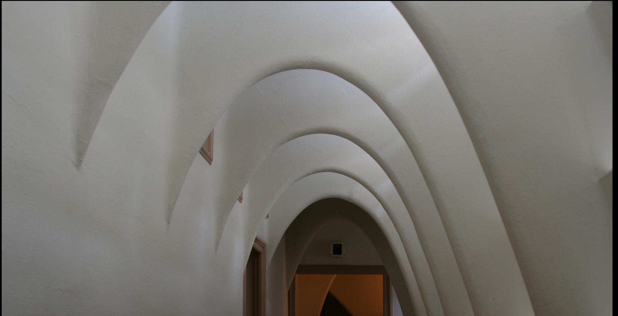
LA CATENARIA HA LA PROPRIETÀ DI AVERE IN OGNI SUO PUNTO UNA DISTRIBUZIONE UNIFORME DEL SUO PESO TOTALE. LE STRUTTURE REALIZZATE SECONDO TALE CURVA SUBISCONO SOLTANTO SFORZI A TRAZIONE, COME LE FUNI DI SOSTEGNO NEI PONTI SOSPESI, OPPURE, IN ALTERNATIVA, A COMPRESSIONE, QUANDO LA STRUTTURA REALIZZATA HA LA FORMA DI UNA CATENARIA ROVESCIAIA, COME NELLE STRUTTURE DI CUPOLE.
